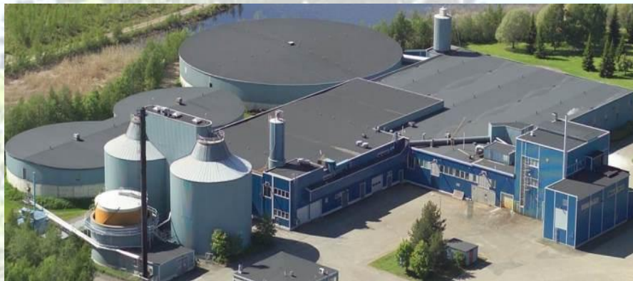
Kuva 10. Kuhasalossa sijaitseva jätevedenpuhdistamo.
