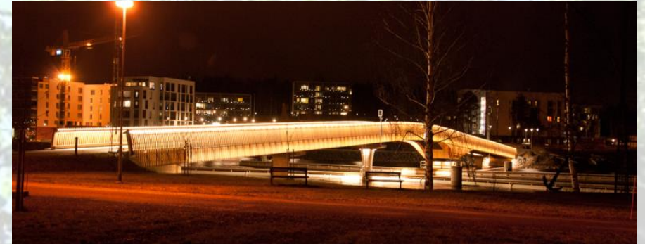
Kuva 19. Ylisoutajansilta on Joensuun ensimmäinen pelkästään kevyelle liikenteelle tarkoitettu silta.
