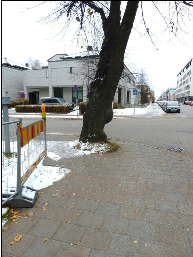
Kuva 43. Torikadun ja Sairaalakadun kulmauksessa jalkakäytävällä oleva puu aiheuttaa törmäysvaaran.
