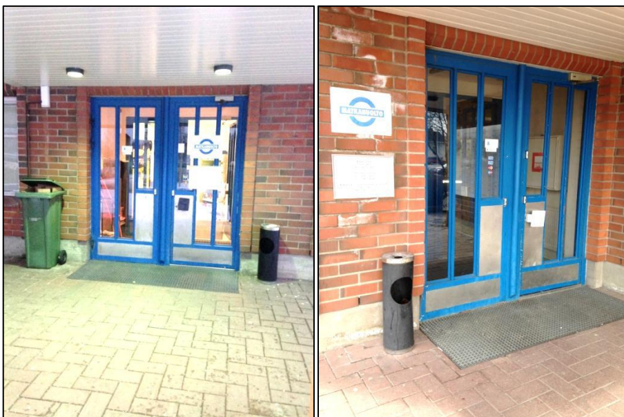
Kuva 110. Linja-autoaseman sisäänkäynnit erottuvat hyvin ympäröivästä seinästä.
