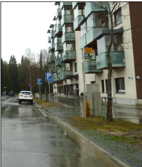
Kuva 88. Senioripihan julkisivu Torikadun puolella.
