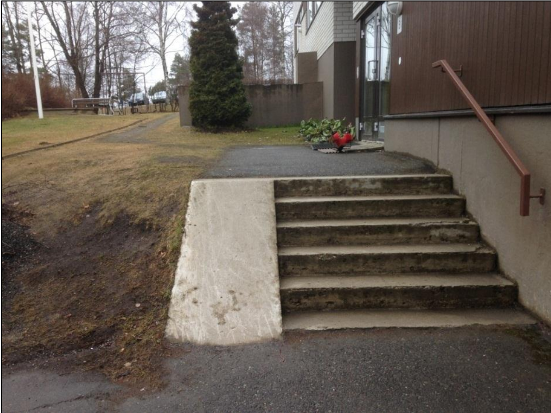
Kuva 148. B-rapun sisäänkäynnille johtava luiska on erittäin jyrkkä.
