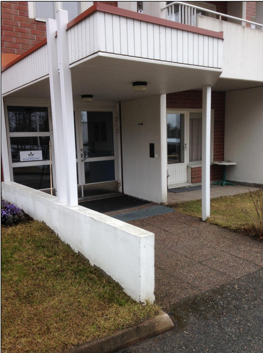
Kuva 140. Rakennuksen sisäänkäynti on esteetön.
