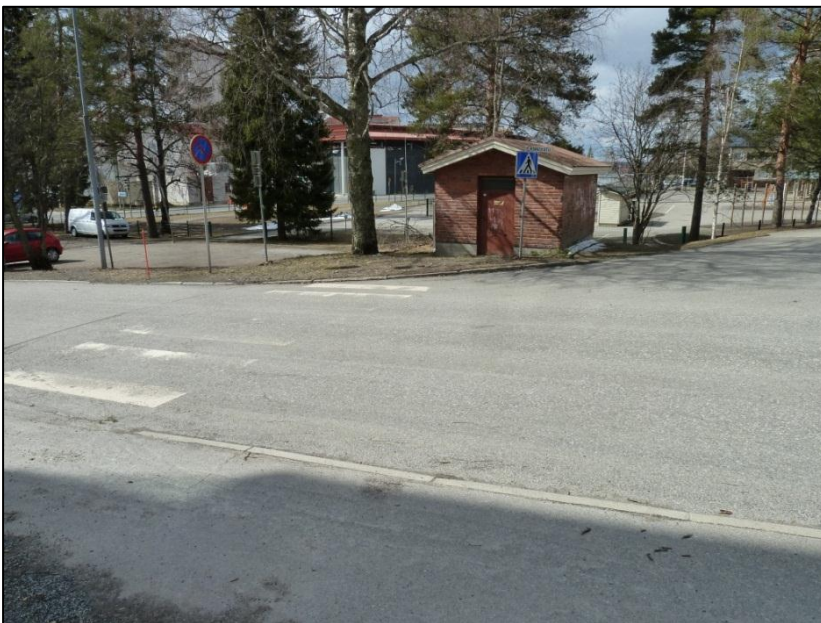
Kuva 49. Kuluneet suojatiemerkinnot vaikeuttavat suojatien paikan hahmottamista.
