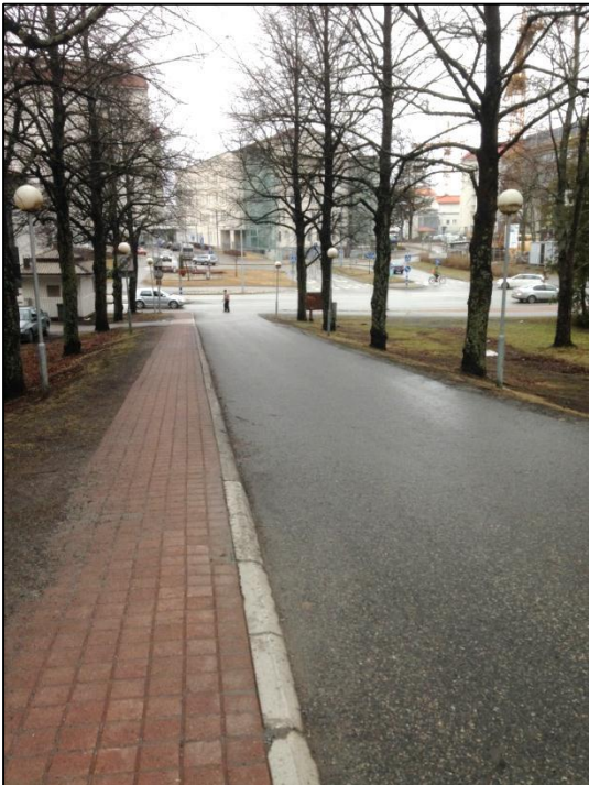
Kuva 78. Tikkamäentieltä Pielisensuun kirkolle johtavan jyrkän väylän yhdelle puolelle tulee lisätä käsijohde.
