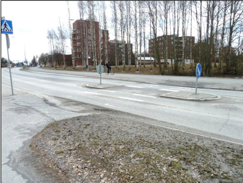
Kuva 80. Suurin osa Niinivaarantien keskisaarekkeista on syvyydeltään alle kaksi metriä. Ne tulee leventää vähintään kahteen metriin.
