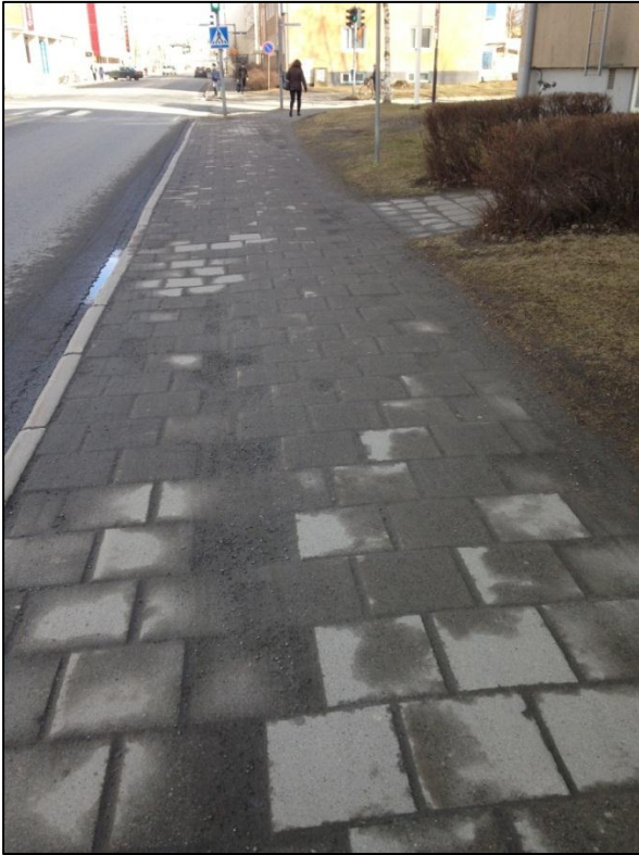
Kuva 65. Epätasaisten laatoitettujen väyläosuksien painumien syy tulee selvittää.
