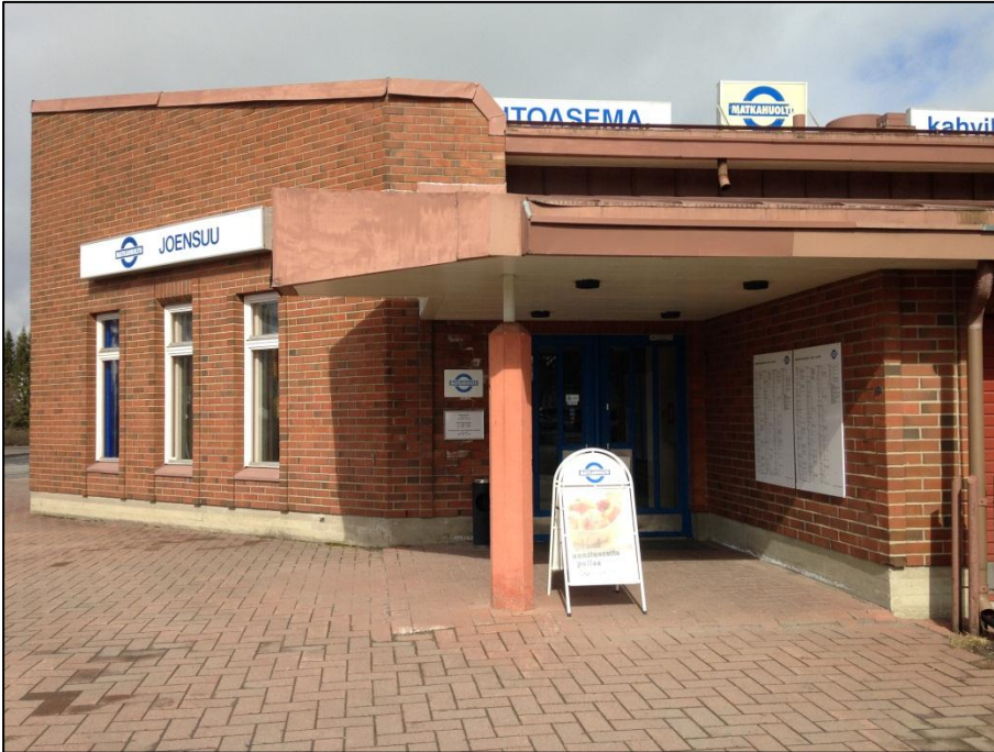
Kuva 111. Mainostaulu on sijoitettu sisäänkäynnin kulkuväylälle, mikä aiheuttaa törmäysvaaran näkövammaiselle henkilölle.
