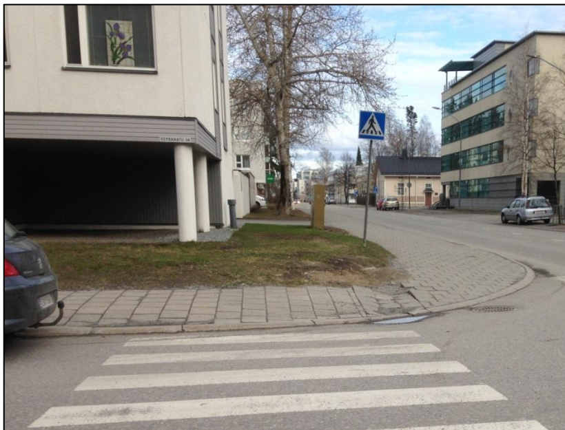
Kuva 67. Suojatiet, joissa reunatuen korkeus on viisi senttimetriä tai yli tulee toteuttaa esteettömyyssohjeiden mukaisesti.
