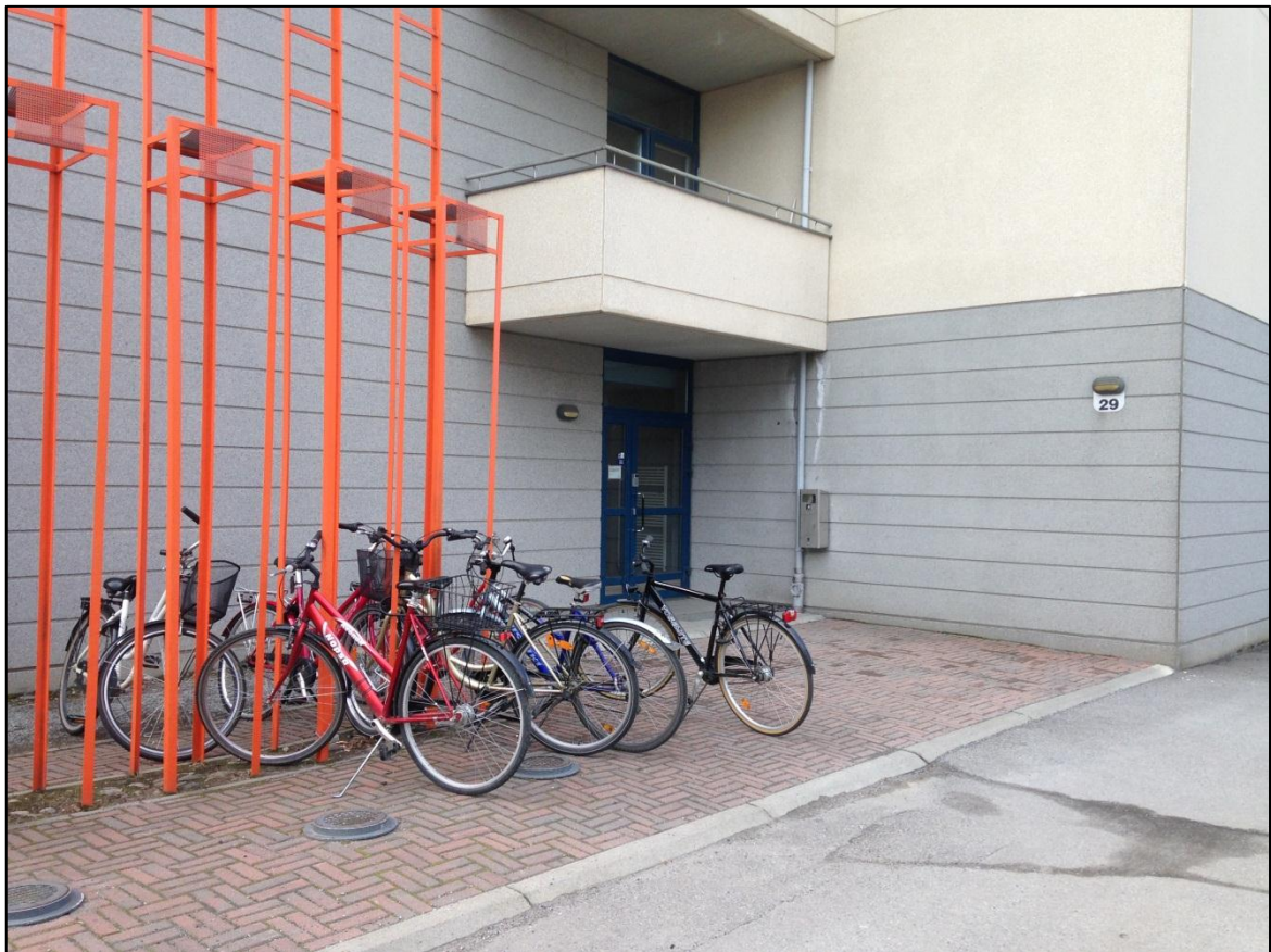
Kuva 137. Rakennuksen sisäänkäynnin edustan ja jalkakäytävän välillä on luiskattu reunatuki.
