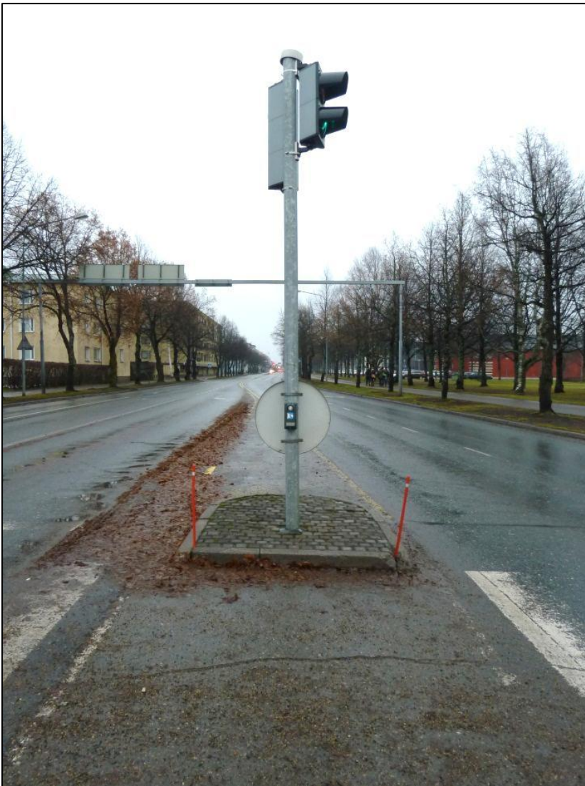
Kuva 68. Alle kaksi metriä syvyydeltään olevat keskisaarekkeet tulee leventää vähintään kaksi metriä leveiksi.
