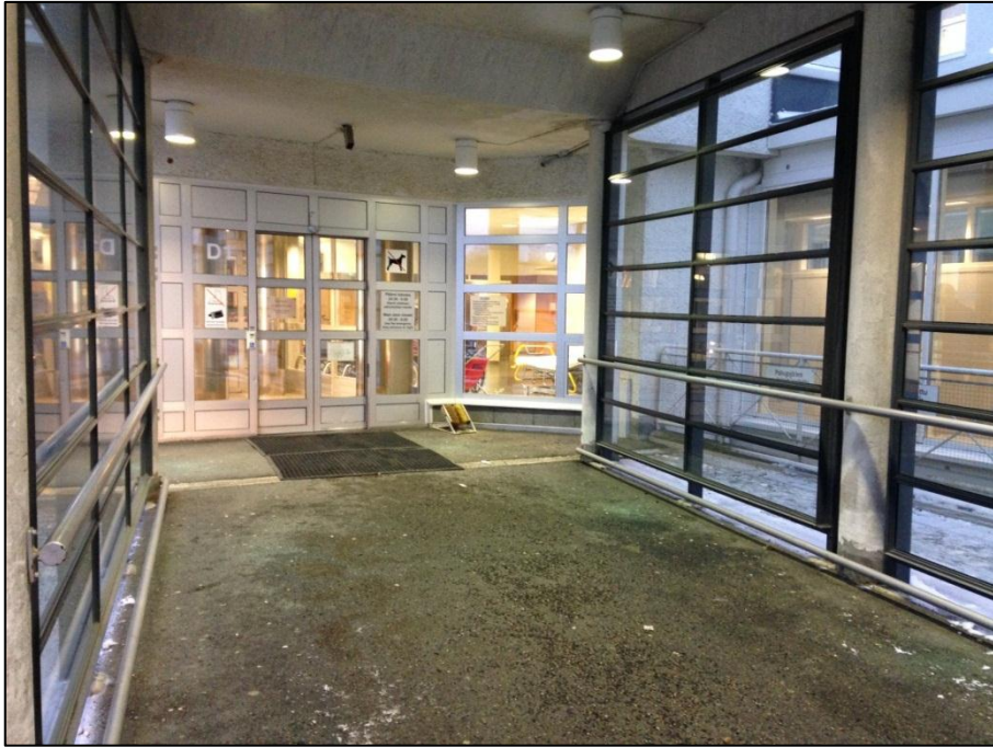
Kuva 106. Keskussairaalan A-talon pääsisäänkäynti.
