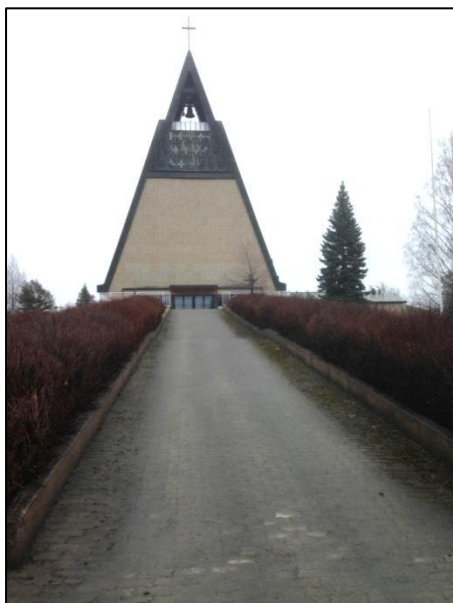
Kuva 120. Kirkon pääsisäänkäynnille johtaa jyrkkä luiska.
