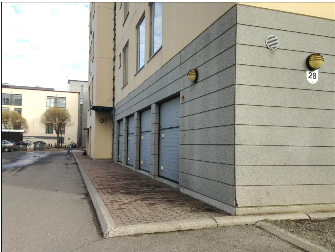
Kuva 139. Rakennuksen piha-alue ja väylät ovat hyväkuntoisia.
