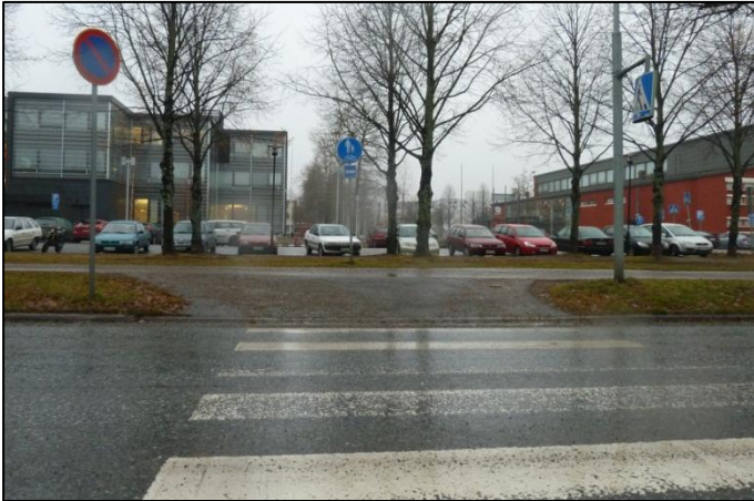
Kuva 15. Väylän kaltevuus suojatielle saavuttaessa voi aiheuttaa vaaratilanteen esimerkiksi pyörätuolilla kulkevalle henkilölle.
