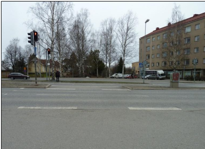
Kuva 17. Reunatuettomassa suojatiessä näkövammaisen henkilö ei pysty hahmottamaan jalkakäytävän ja ajoradan reunaa. Suojatien hahmottamista vaikeuttaa myös kulunut suoja-tiemerkintä.
