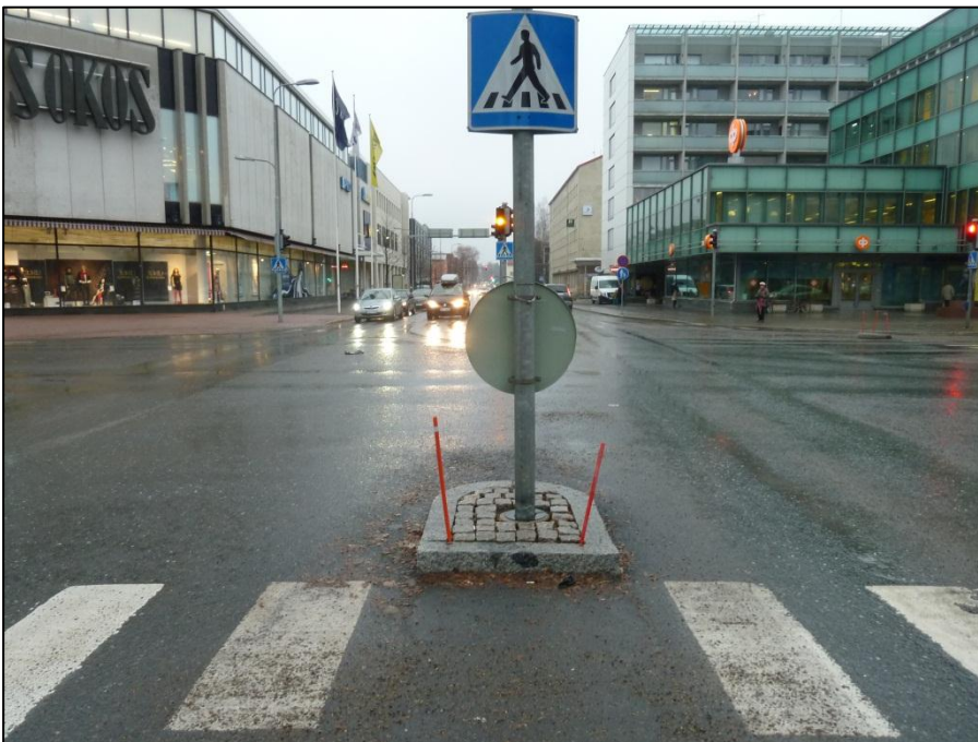
Kuva 22. Liian kapealla saarekkeella ei ole riittävästi tilaa lastenvaunuille tai pyörätuolille.
