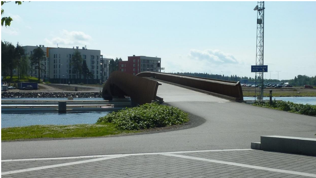
Kuva 2. Penttilänrannan ja ydinkeskustan yhdistävä pyöräilijöille ja jalankulkijoille tarkoitettu Pielisjoen ylittävä Ylisoutajan silta.
