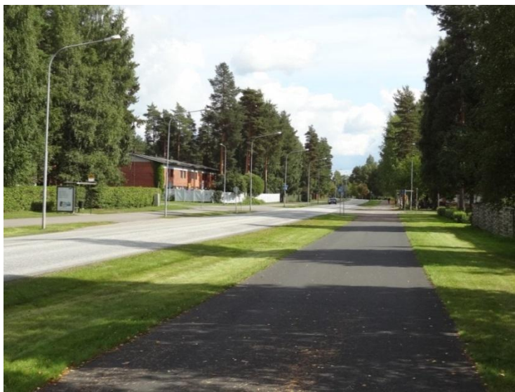
Kuva 5. Yhdistetty pyörätie ja jalkakäytävä molemmin puolin katua Utrantiellä Ruuhitien ja Ranta-Mutalantien kohdalla.
