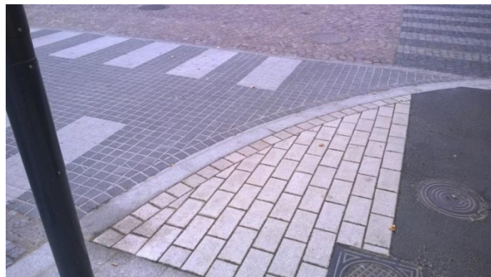
Kuva 28. Toimiva reunakiviratkaisu, jossa pyörätiellä ei ole tasoeroa, Uusikatu Kauppurienkadun ylityksen kohdalla Oulussa.
