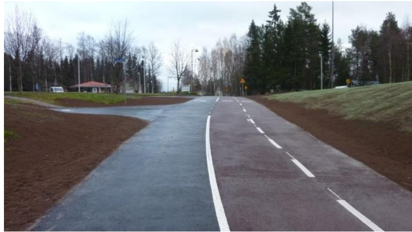
Kuva 23. Kaksisuuntainen pyörätie Kempeleessä. Erottelutapana on tiemerkinä.
